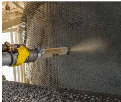
Strukturelle Verstärkung mit S&P ARMO-mesh® und ARMO-crete®
