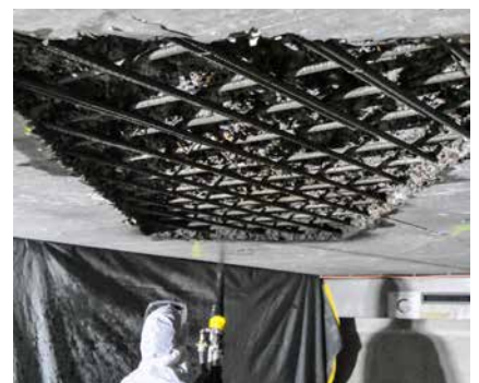
Betonsanierung mit S&P ARMO-crete®
