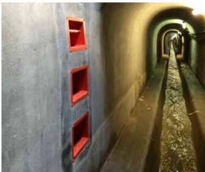
Kanal- und Leitungsbau
