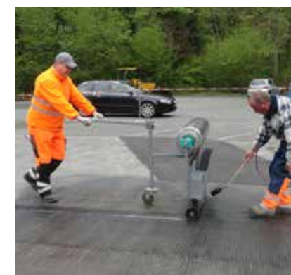
4 Handeinbau der S&P Asphaltbewehrung bei Teilflächen
