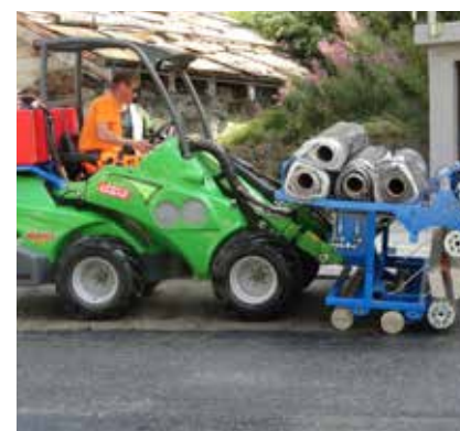
3 Maschineller Einbau der S&P Asphaltbewehrung, vollflächig auf gebrochener Emulsion
