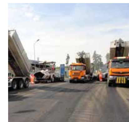
5 Belagseinbau am gleichen Tag
