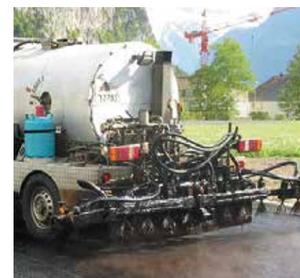
2 Applikation der Haftemulsion auf trockenem und staubfreiem Traggrund
