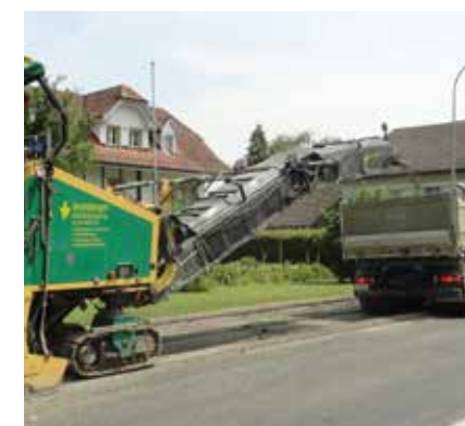
1 Vorbereitung des Traggrundes mit Fräsen und/oder Nassreinigung
