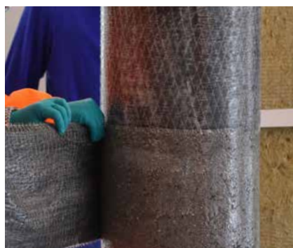
Axiale Stützenverstärkung mit S&P C-Sheet 240
