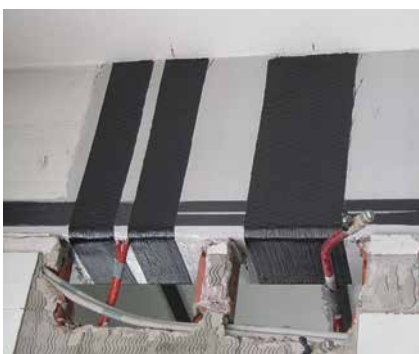
Schubverstärkung mit S&P C-Sheet 640
