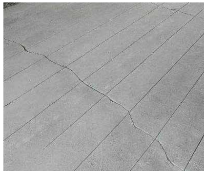
Biegeverstärkung mit eingeschlitzten S&P C-Laminaten
