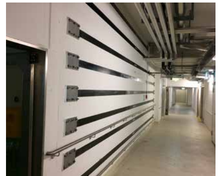
Schubverstärkung mit vorgespannten S&P C-Laminaten
