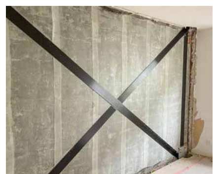
Erdbebenverstärkung mit S&P G-Sheet und S&P C-Laminaten
