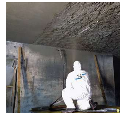
4 Hochbau (Erdbebensicherung, Stützenverstärkungen)
