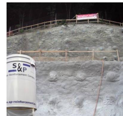
5 Tiefbau (Baugrubensicherung, Stützmauern)
