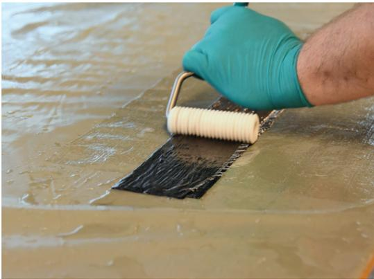
Nach dem Falten das Epoxidharz erneut mit einem Gummispachtel (Squeeze) und einem Teflon-Anpressroller **nur in Faserrichtung (längs)** einarbeiten.
