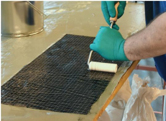
Das S&P C-Sheet mit S&P Epoxidharz vorimprägnieren.
