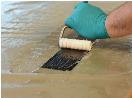
Après le pliage, appliquer à nouveau la résine époxy avec une spatule en caoutchouc (S&P Squeeze) et un rouleau de pression en téflon **dans le sens de la fibre (dans le sens de la longueur) uniquement.**
