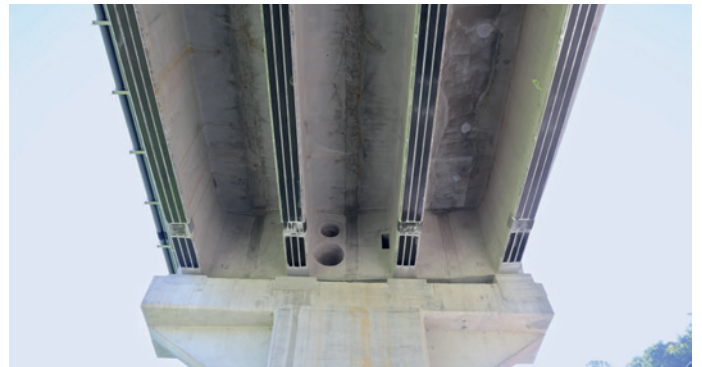
Oben: Brückenuntersicht mit Lamellen und Schubverstärkung. Unten: Brückenuntersicht mit Lamellen und C-Sheet gegen Delaminieren.
