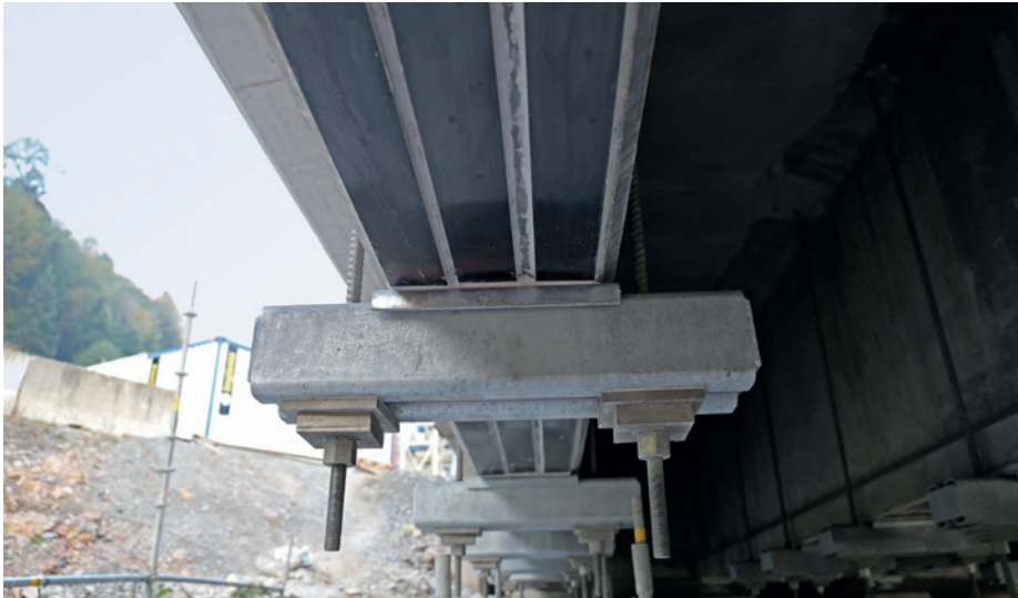
Detail Schubverstärkung mit Lastverteiler-Konstruktion
