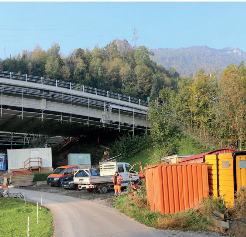
Gesamtansicht der Zwillingsbrücken.
