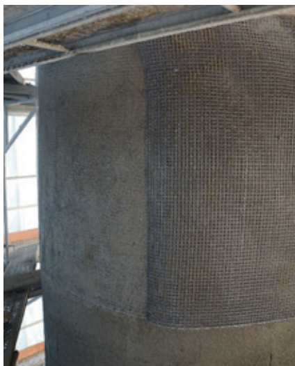
Einarbeiten des S&P ARMO-mesh in die erste Lage S&P ARMO-crete w RQ
