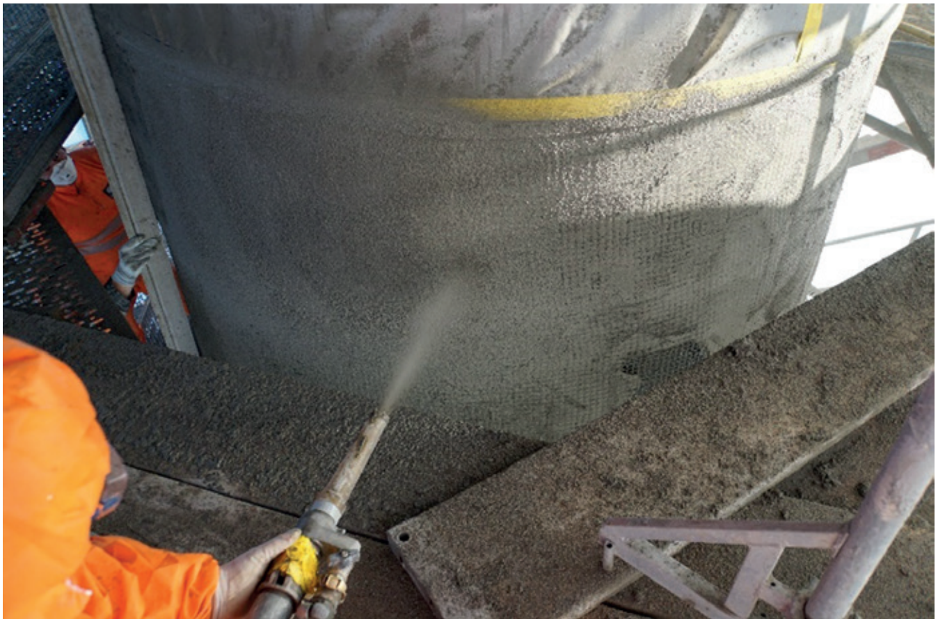
Überspritzen der Carbonbewehrung mit zwei Zentimeter Spritzmörtel
