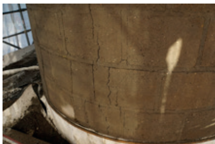
Vorbereiteter Untergrund zur Aufnahme des S&P ARMO-Systems
