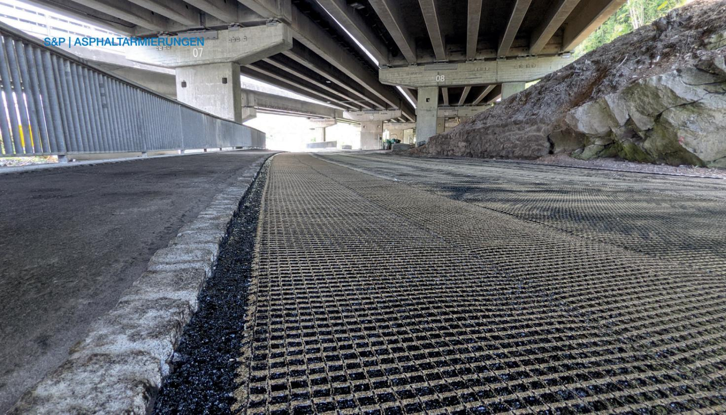
**Aufgrund der Vorbituminierung haftet die Asphaltbewehrung, sie lässt sich somit effizient verlegen.**
