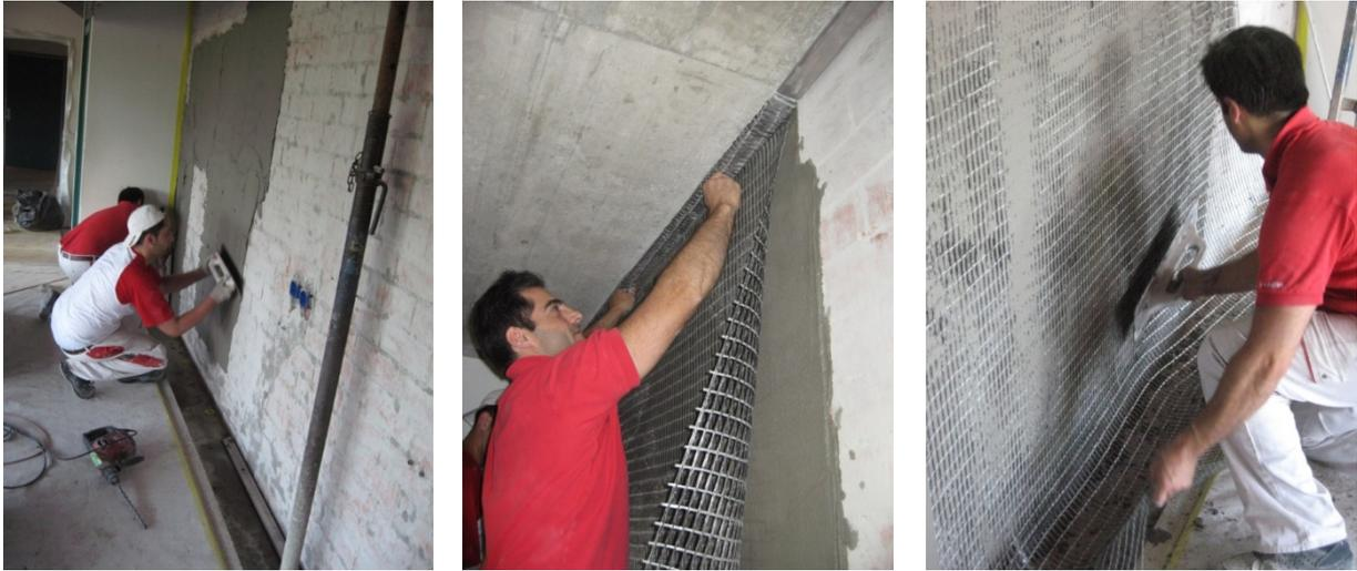
Images 26 / 27 / 28: renforcement sismique avec le système ARMO
