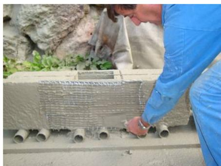
Image 4 : Application du mortier projeté et S&P ARMO-mesh L500
