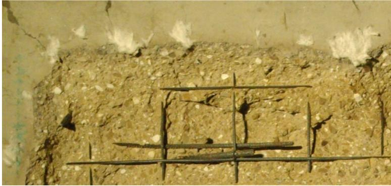
Image 32: éclatement de la base en béton
