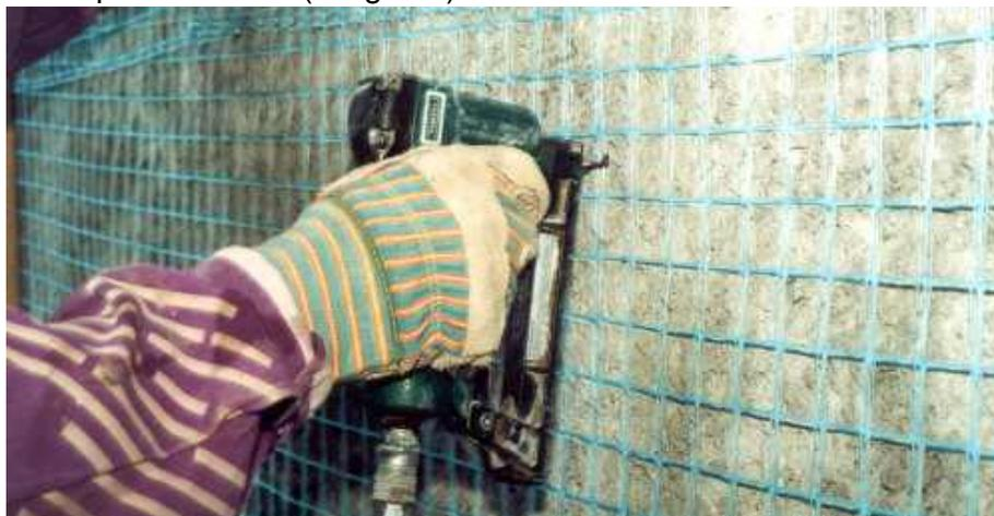
Image 14: Fixation du treillis S&P ARMO-mesh avec des agrafes
