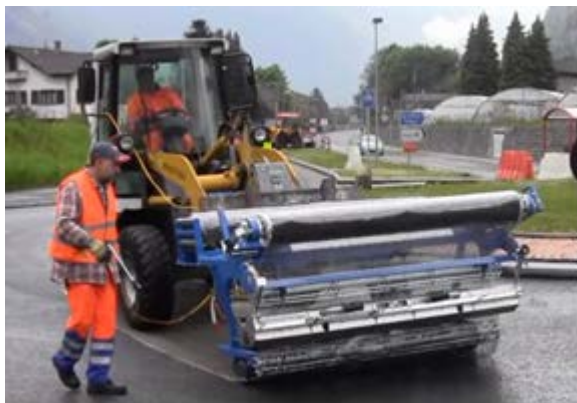
Photo 9 : Mise en place de S&P Carbophalt G
