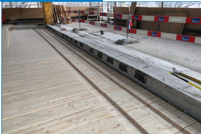
▲ Übergang Unterzug neue Holz- / Beton-Verbunddecke
