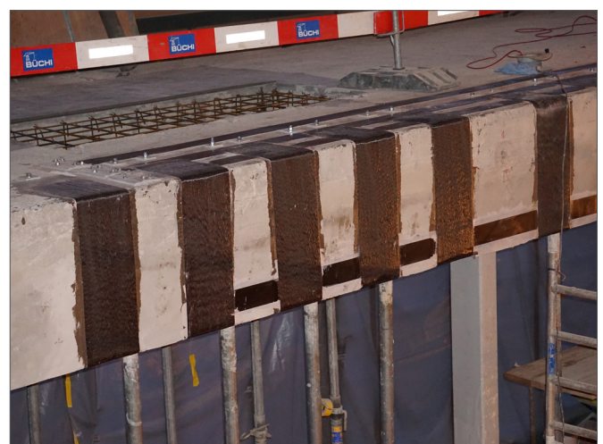
▲ S&P C-Sheet 240 400 g/m 2 mit Verankerung auf Decke
