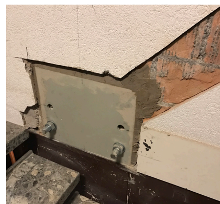
▲ Ancrage des plaques de base FLB
