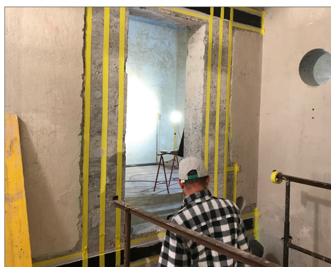
▲ Applikation der horizontalen Lamellen in 1. Lage
