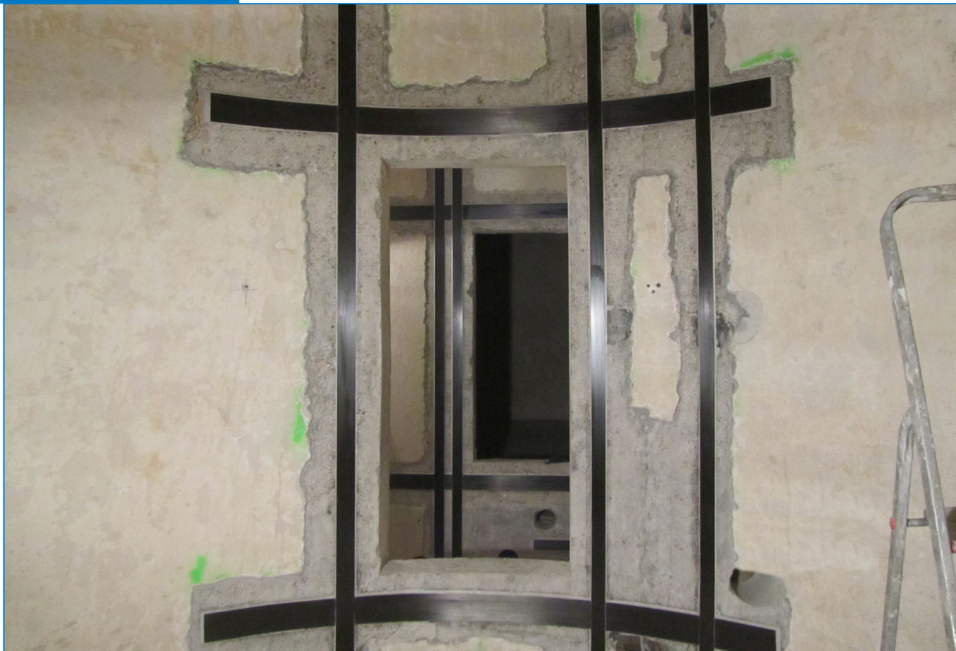
▲ Ansicht fertige Applikation der S&P C-Laminate
