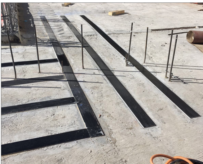
▲ Applizierte Lamellen auf der Deckenoberseite
