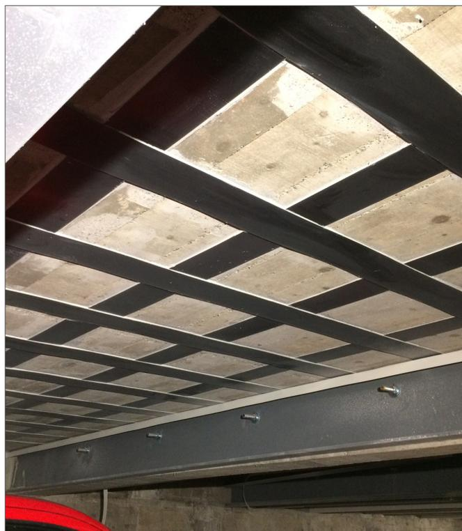
▲ Dalle renforcée avec lamelles carbone et profilés métalliques
