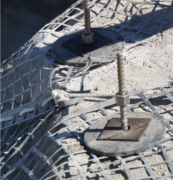
▲ Netz hinter der Kante befestigen
