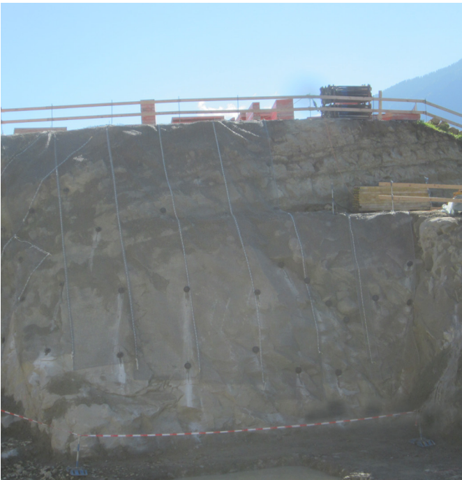
▲ Fertige Baugrubensicherung
