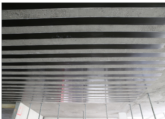
▲ Application des lamelles de carbone en sous-face de dalle
