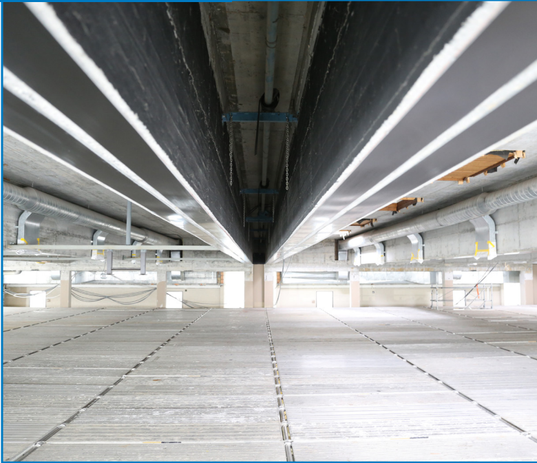
▲ Untersicht Doppel-Unterzug mit je 2 S&P C-Laminate 150/1.4
