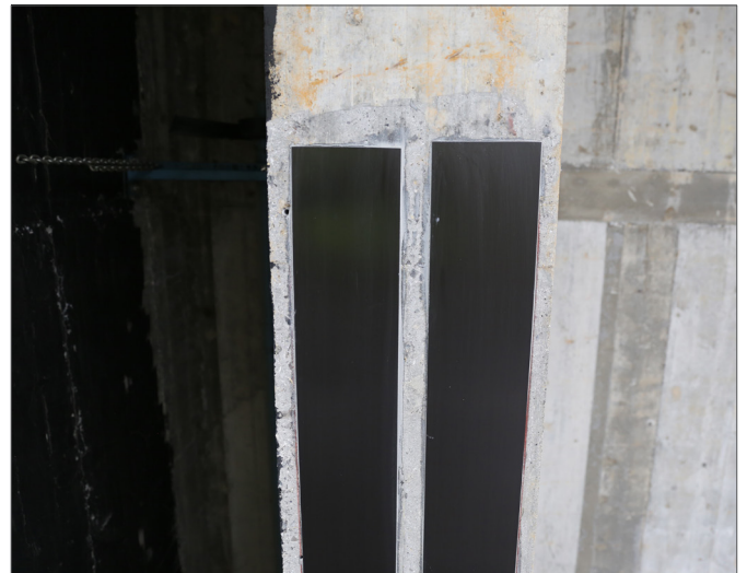
▲ Verankerungsstrecke der S&P C-Laminate
