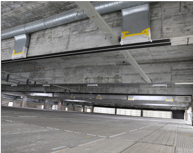
▲ Untersicht der Turnhallendecke mit den verstärkten Trägern
