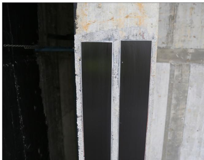
▲ Zone d'ancrage des lamelles carbone
