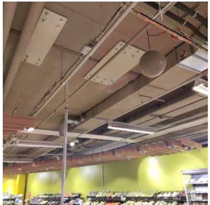
▲ Stahlplatten über den Dilatationsfugen verbinden die beiden Gebäudeteile.
