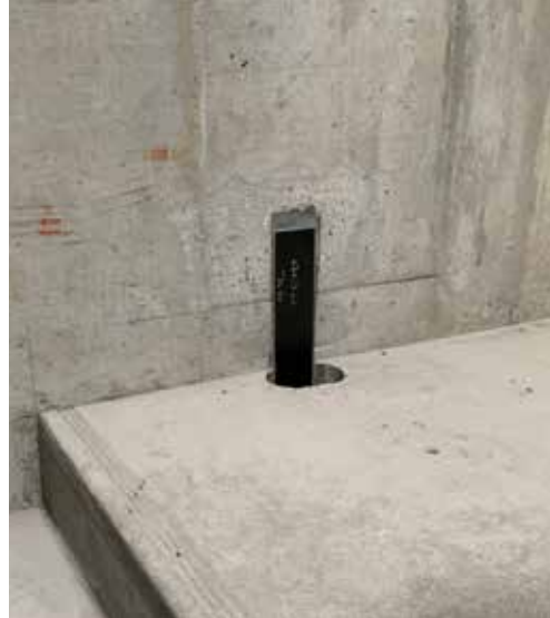
▲ Das obere Ende der Lamelle ist für die Verankerung vorbereitet.
