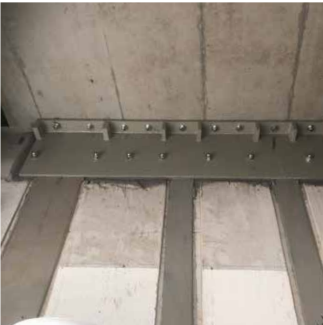
▲ Die Spezialverankerungen aus Stahl sind mit einer Epoxy-Beschichtung versehen.
