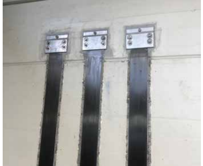
▲ An den Enden kamen S&P Standard-Endverankerungen zum Einsatz.
