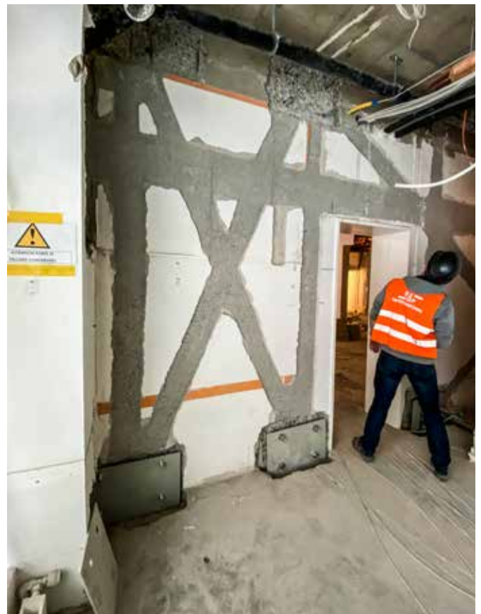
▲ Un spécialiste S&P vérifie la qualité et l'exécution des travaux.
