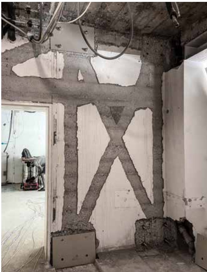
▲ Le support est préparé et les premières plaques de base pour les cornières métalliques sont montées.
