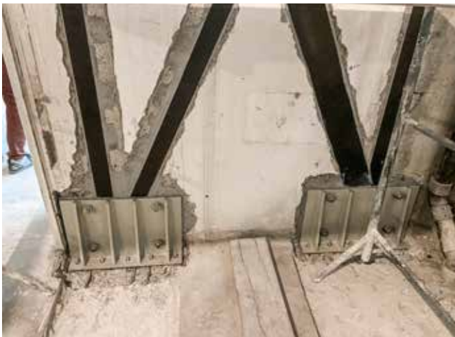
▲ Vue des cornières métalliques fabriquées sur mesure par S&P
