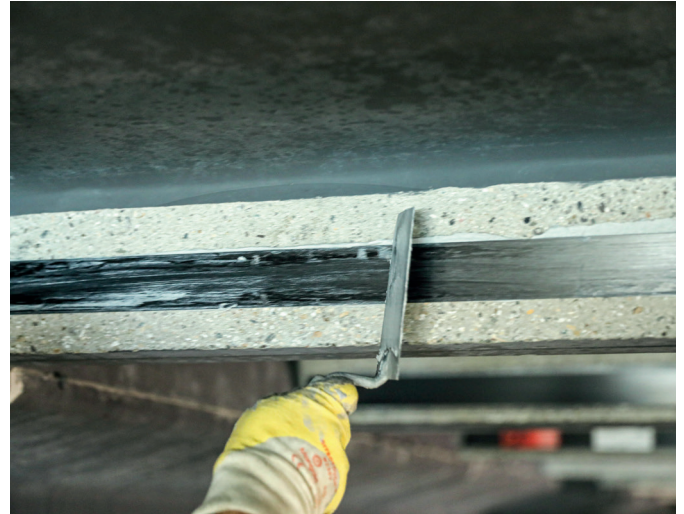
▲ Les S&P C-Laminate sont collés sur les éléments préparés. Image: S&P
