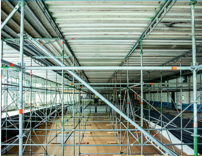
▲ Un grand échafaudage de surface garantissait l'accès. Image: S&P
