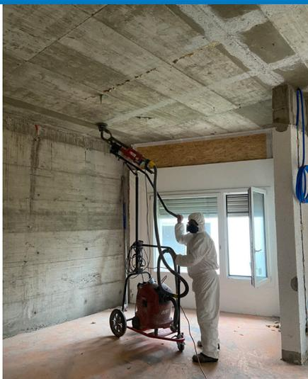
▲ Préparation et ponçage du béton support à l'aide d'une ponçeuse girafe
