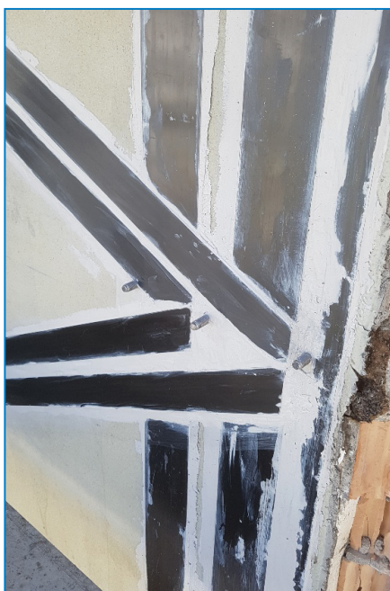
▲ Application des S&P C-Laminate avec la S&P Resin 220.
