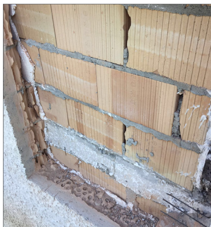
▲ Enlèvement du crépi et de l'isolation. Vue du mur en brique extérieure.
