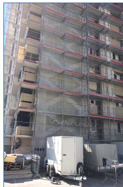
▲ Aperçu d'une façade renforcée avant la pose de l'isolation.
