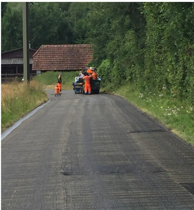
▲ Vollflächig verstärkte Strasse mit S&P Carbophalt® G
