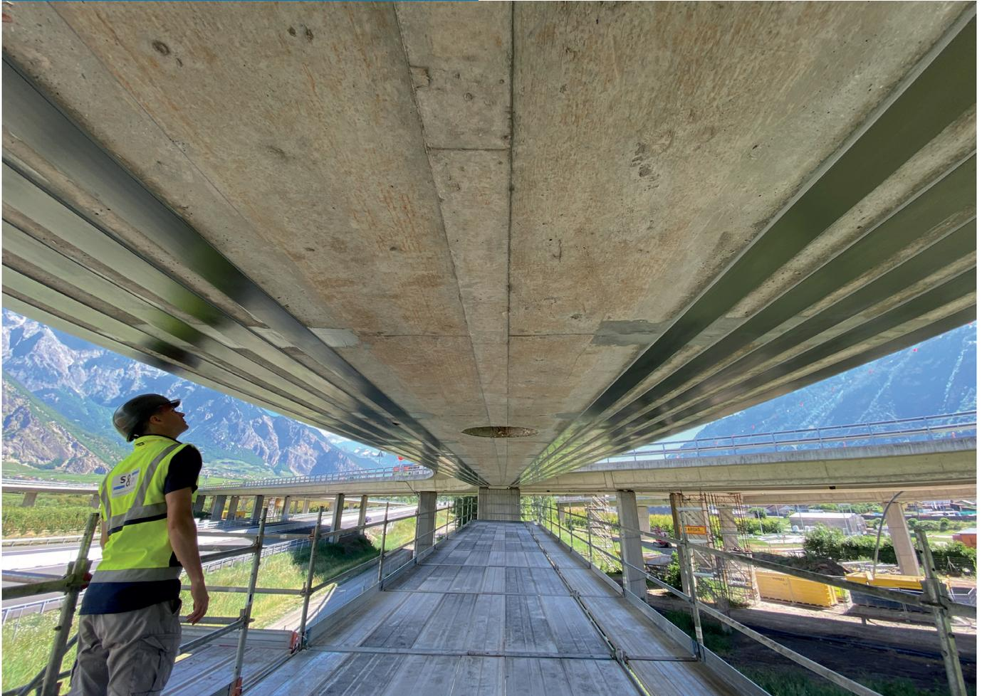
▲ Spannweite von 26m, verstärkt mit S&P C-Laminaten.
