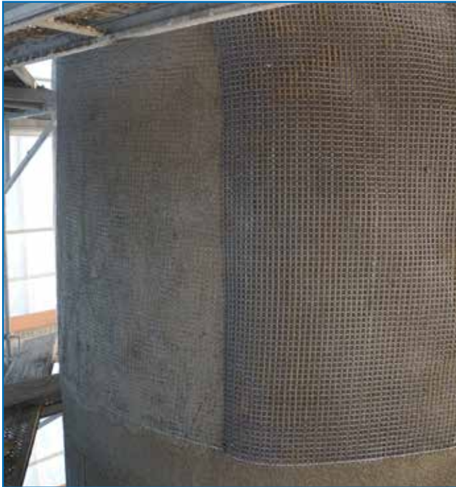
▲ Einarbeiten des S&P ARMO-mesh in die erste Lage S&P ARMO-crete® w RQ
