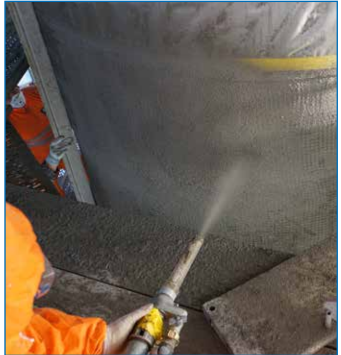
▲ Ueberspritzen der Carbonbewehrung mit 2 cm Spritzmörtel
