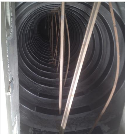
▲ Temporäre Sicherung der Verstärkungsmassnahme in der Fluchtröhre
