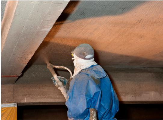
Auftragen der zweiten Lage des S&P ARMO-crete® w in die noch nicht abgebundene erste Mörtelschicht (nass in nass). Sobald der Abbindevorgang begonnen hat, kann der Mörtel auf die gewünschte Stärke abgezogen und taloschiert werden.
