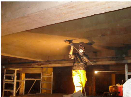
Die Zementhaut der ersten Schicht ist vor dem Aufbringen der zweiten Lage zu entfernen!
