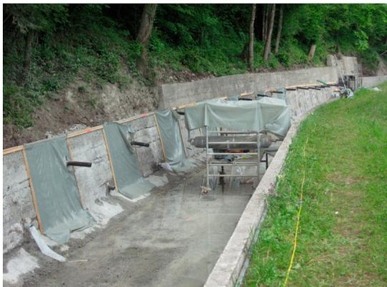
Bis 7 Tage nach der Verarbeitung soll der Spritzmörtel gegen grosse Hitze und Windeinwirkung abgedeckt und feucht gehalten werden.
