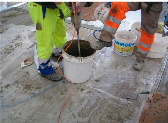
Der S&P ARMO-crete® w Sack von 25 kg wird je nach Konsistenz des Spritz-mörtels mit 3,6–3,8 Liter Wasser aufgemischt. Das Mischen von 3 Minuten erfolgt mit einem mechanischen Mischer bis ein homogenes Gemisch entsteht. Das Gemisch soll ca. 1 Minute liegen. Vor dem Applizieren nochmals 10 Sekunden aufmischen.
