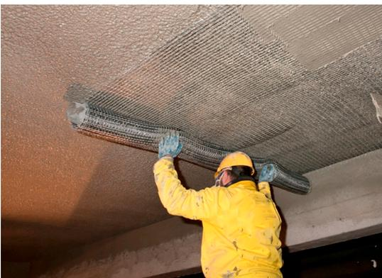
Einarbeiten des S&P ARMO-mesh® in den noch frischen S&P ARMO-crete® w . Das S&P ARMO-mesh® wird dabei mit einer Traufel in den Mörtel gedrückt. Es soll darauf geachtet werden, dass die Fasern der Bewehrung möglichst gestreckt sind.
