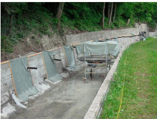
Bis 7 Tage nach der Verarbeitung soll der Spritzmörtel gegen grosse Hitze und Windeinwirkung abgedeckt und feucht gehalten werden.
