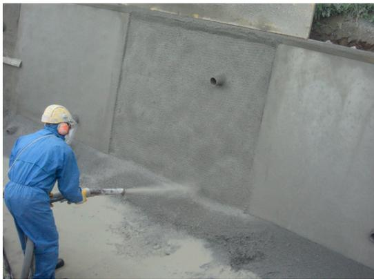
Vor dem Aufbringen der zweiten Lage Spritzmörtel ist der Untergrund mittels Wasserdruck von ca. 150 bar gründlich zu reinigen
